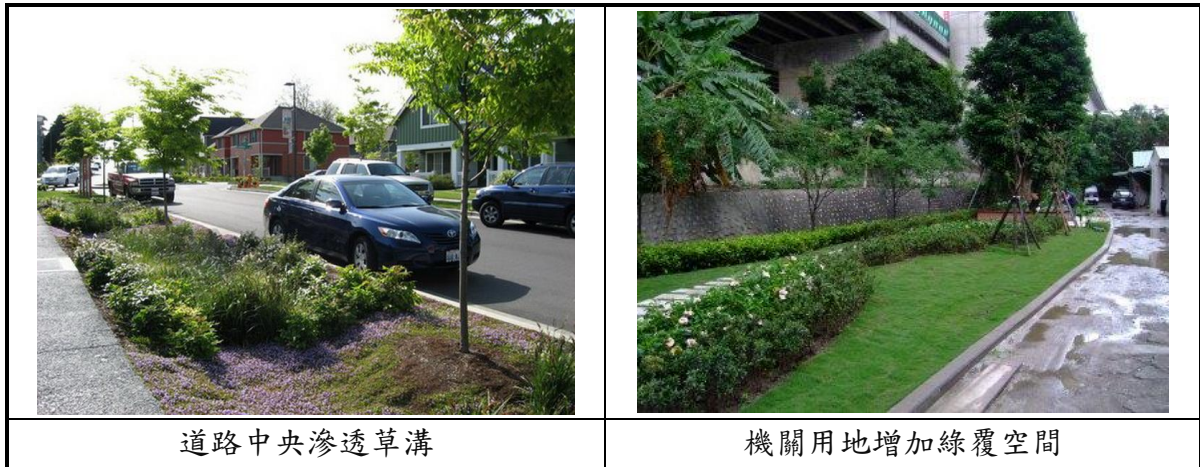
照片 5-2 公共設施用地設置小型滯洪空間案例照片
