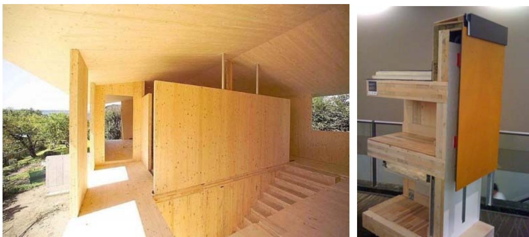
圖 5-3 CLT 結構型態及系統
