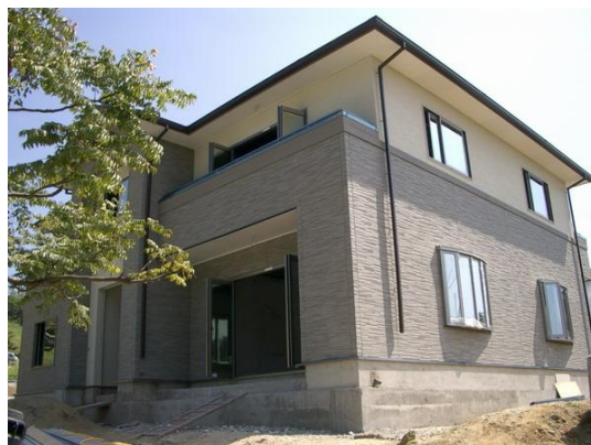
圖 1.2 輕鋼構建築(一般住宅)
