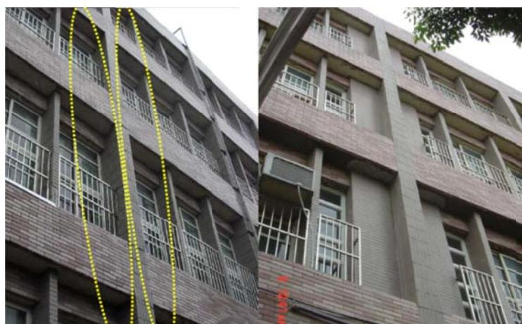
圖 2.9 翼牆補強前後比較圖
