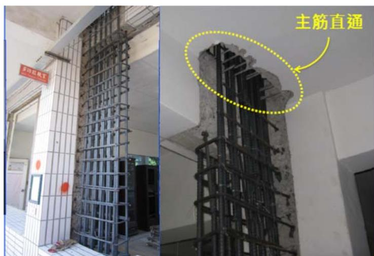
圖 2.8 翼牆偏移主筋直通施工照
