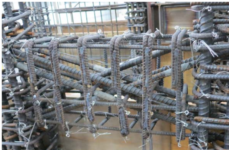
(b) 施工實際情形
