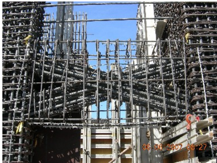
圖 2-4 鋼筋混凝土耦合剪力梁施工細部 (資料來源 http://sitemaker.umich.edu/nees.hpfrc.project/the_motivation )
