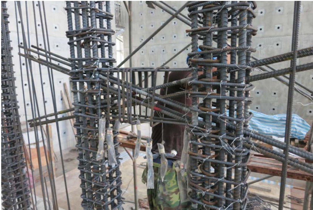
圖 3-19 試體 CW-RC 施工圖 (資料來源 研究製作)
