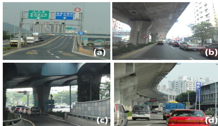
圖 3.2 GNSS 訊號遮蔽之環境
