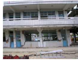
圖 4 耐震補強工法之現地實驗驗證
