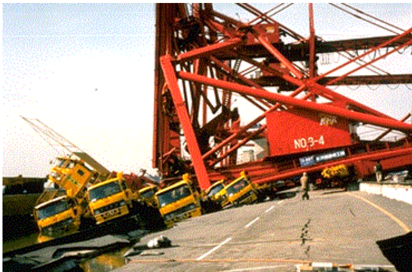
圖 1.1 神戶地震沉箱側移引起設備破壞
