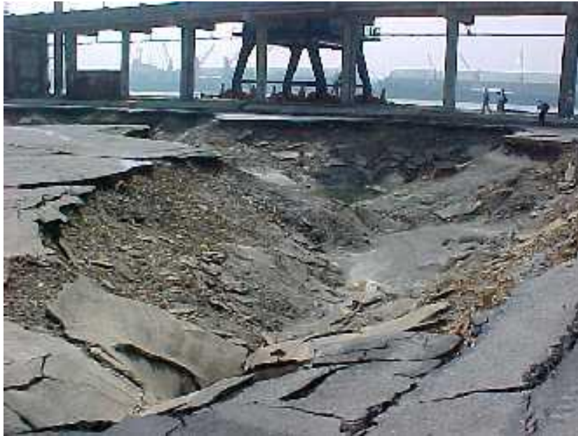
圖 1.4 集集地震臺中港土壤液化引起破壞
