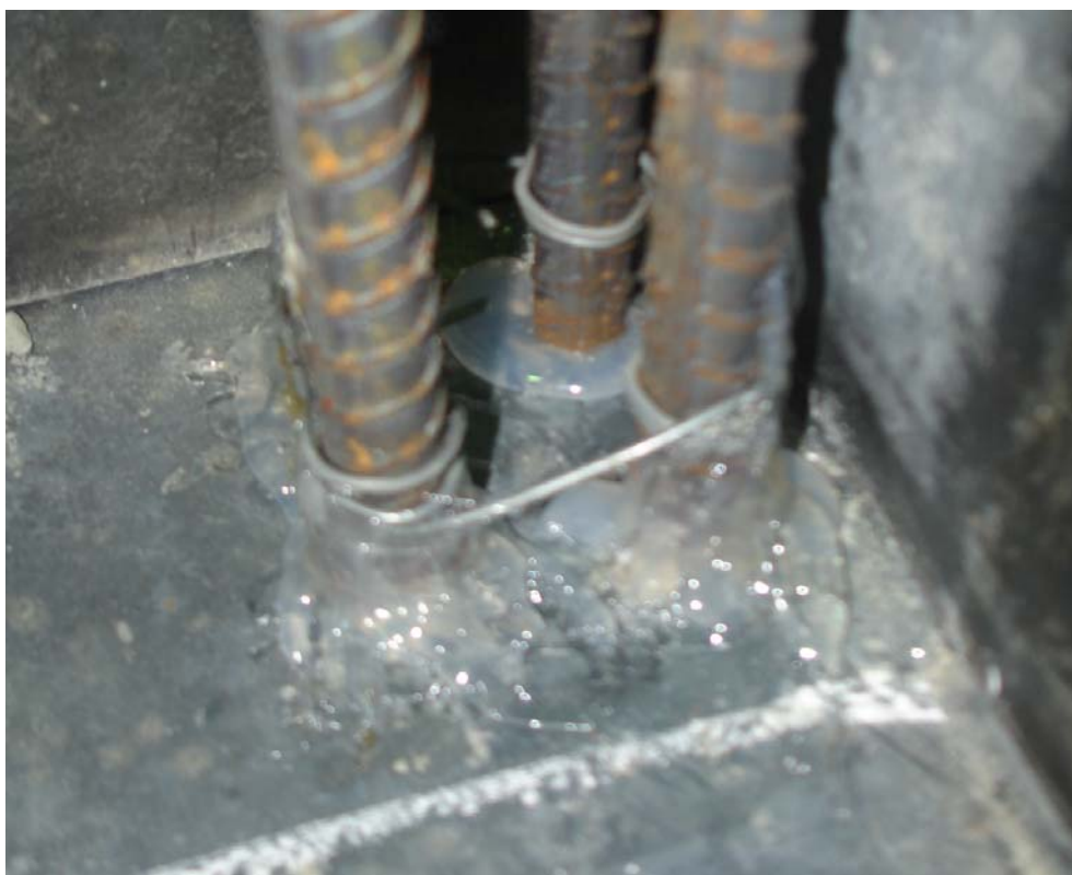
圖 5.12 將鋼筋以熱熔膠固定在底板並加以補強
