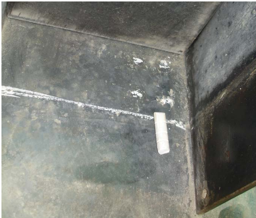
圖 5.11 以粉筆在底板上標記鋼筋位置
