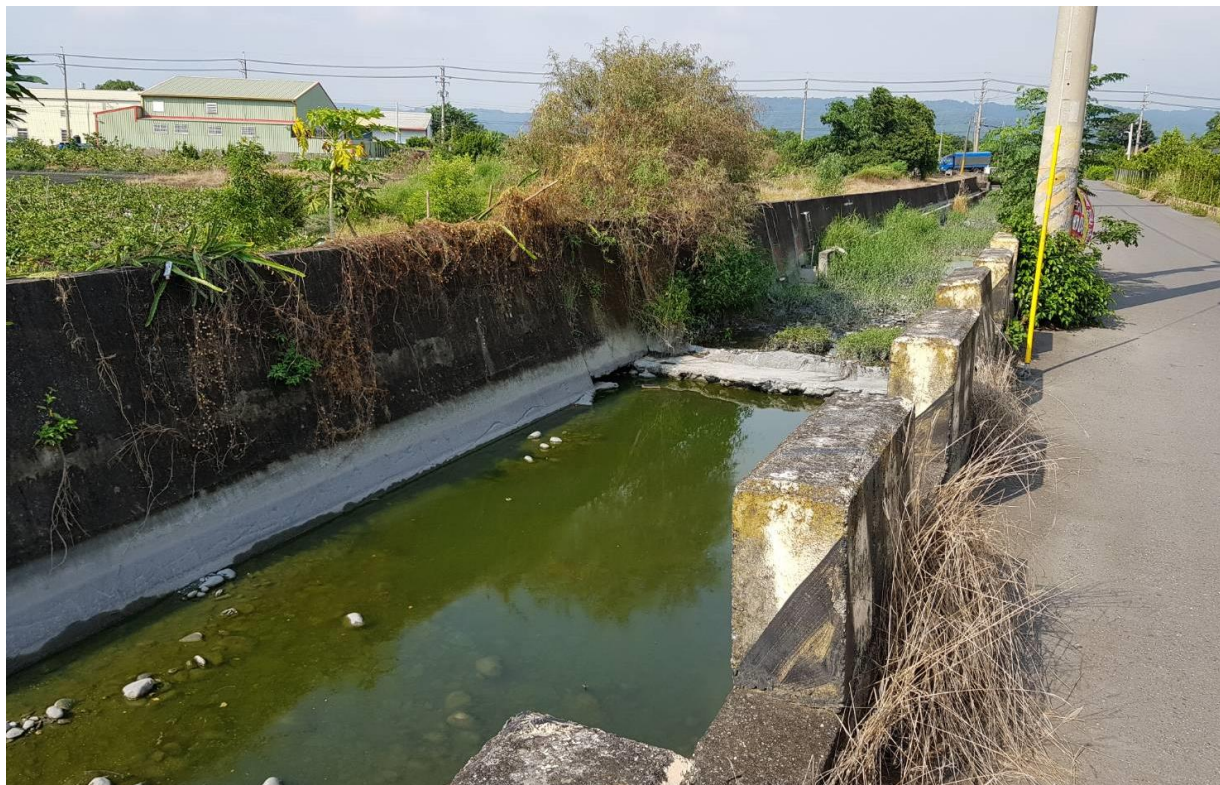
圖 4-7 機構五大門前排水溝
