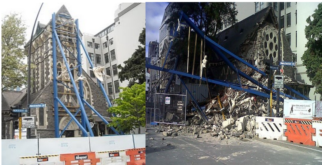
圖 2- 4：第二次地震中倒塌的紐西蘭基督城磚造教堂
