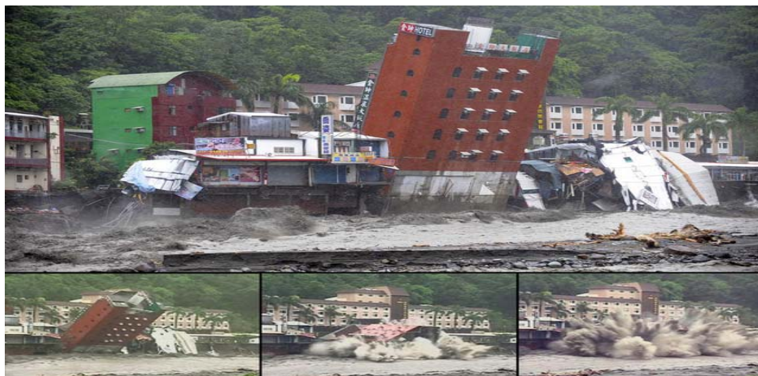
圖 2- 14：台東金帥飯店因地基被洪水掏空而倒塌
