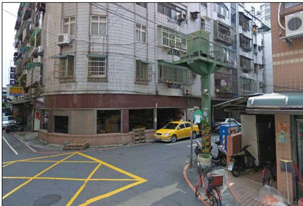
圖 5-18 示範案例第三區 C2 永安 XX 旁舊式公寓群無線地空間與透水鋪面
