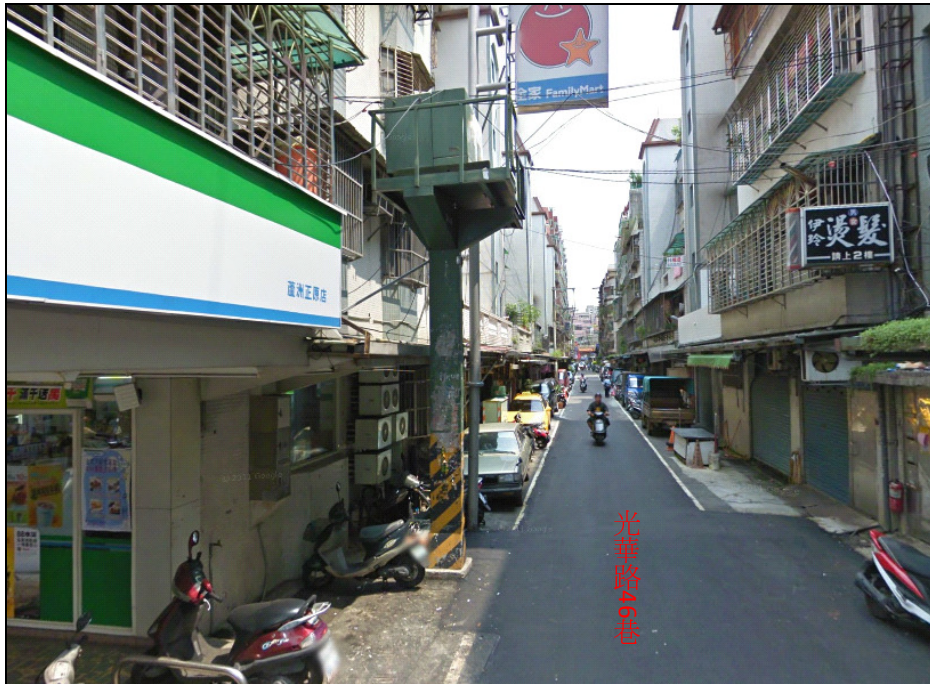
圖 5-6 示範案例第一區（新北市蘆洲區光華里）附近變電箱高架
