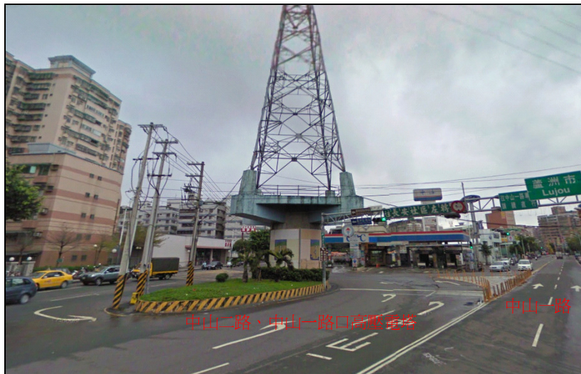
圖 5-15 示範案例第三區 (新北市蘆洲區永安里) 附近高壓電塔架高約有 4 層樓高
