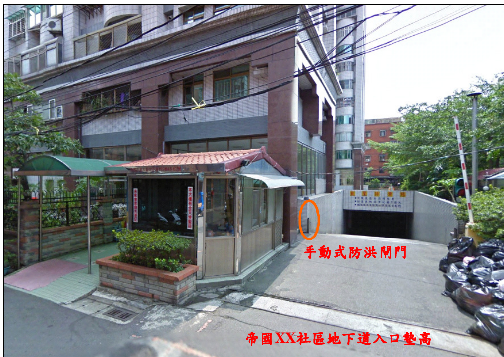
圖 5-9 示範案例第一區 A1 帝國 XX 地下室入口墊高且有手動式 防洪閘門
