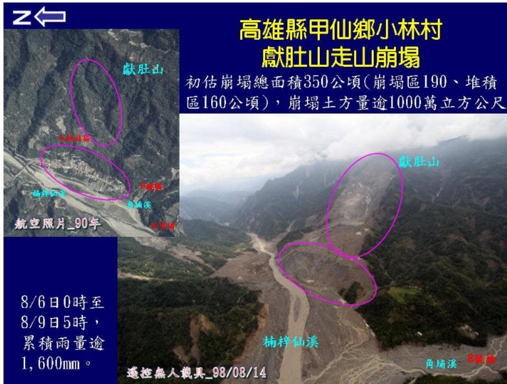
圖 4-3 2009 年莫拉克颱風高雄縣甲仙鄉小林村崩塌情況
