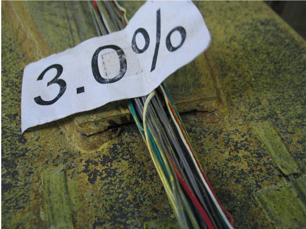
照片 5-5 試體 EC 於尖峰位移角 0.03 弧度時，蓋板尖端開裂情況 (資料來源：本研究製作)
