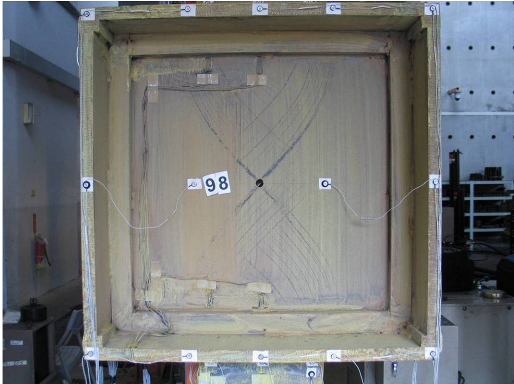
照片 4-19 試體 EE+8 於試驗位移為 97.5mm 時，柱內隔板之掉漆情況 (資料來源：本研究製作)
