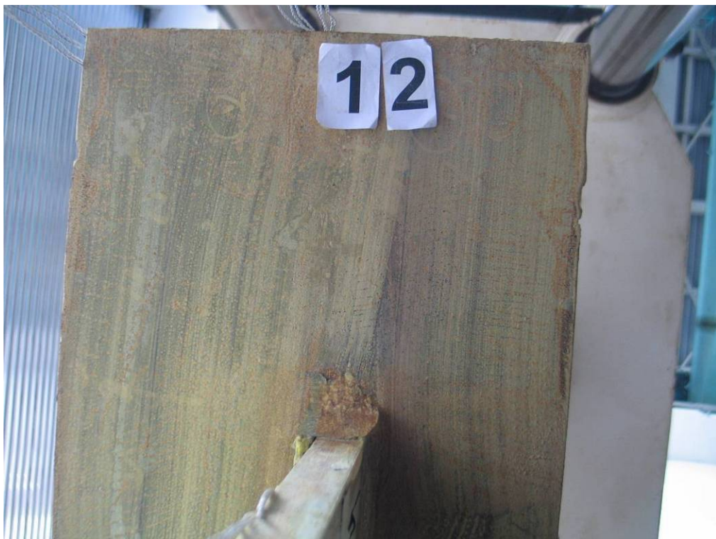
照片 4-28 試體 EE+25 於試驗位移為 12.4mm 時，柱板之掉漆情況 (資料來源：本研究製作)
