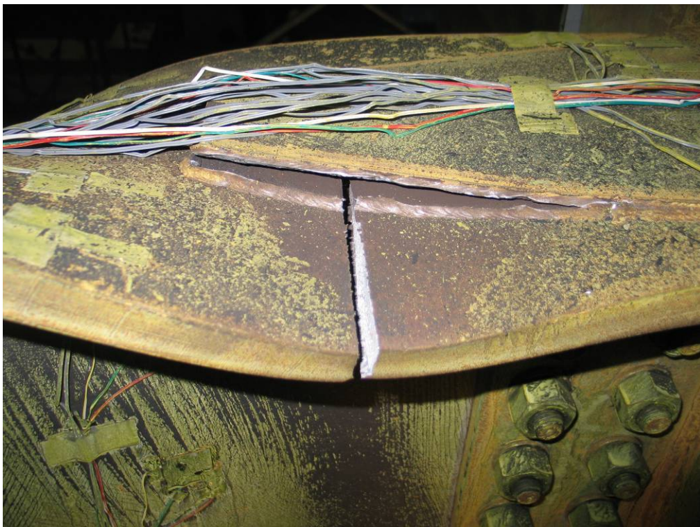
照片 5-8 試體 EC 於尖峰位移角 0.05 弧度第二迴圈時，上翼板斷裂情況 (資料來源：本研究製作)
