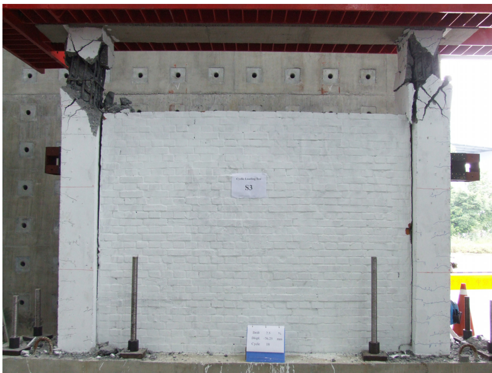
圖 5-21 試體 S3 於位移達 61mm 時短柱處之核心混凝土嚴重損壞 (資料來源：本研究製作)
