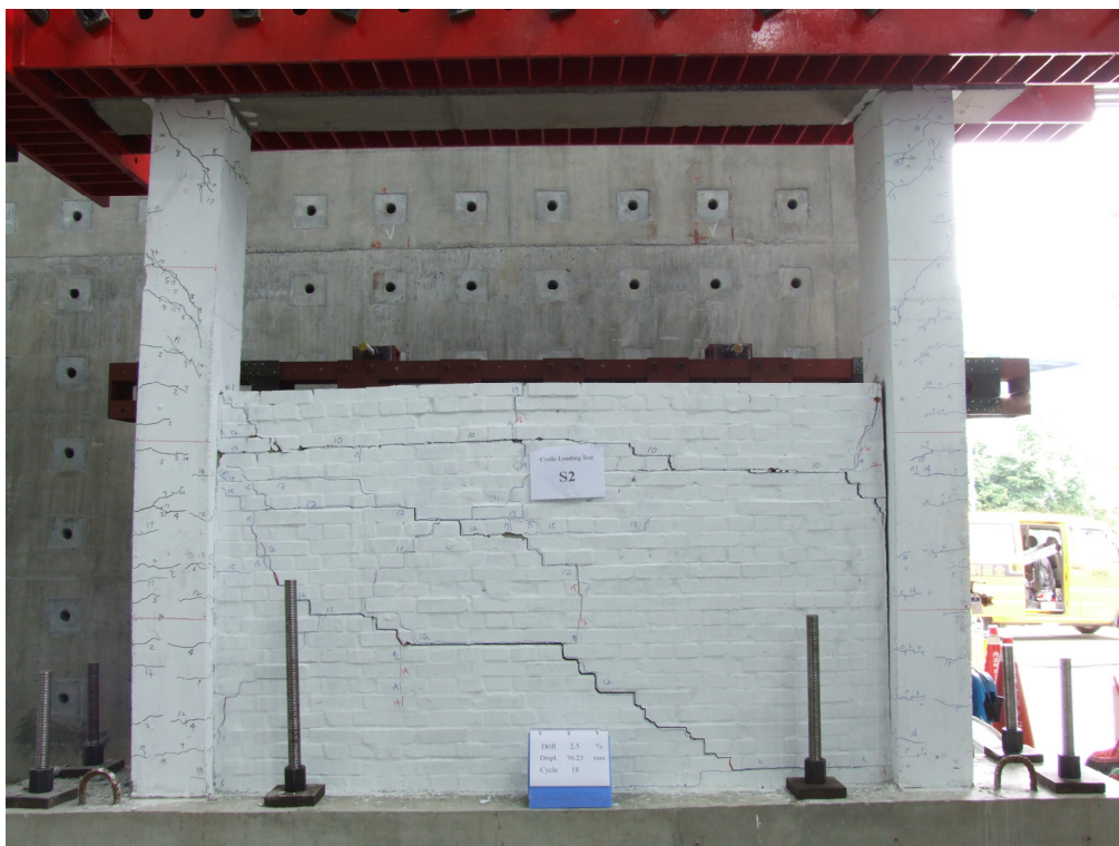
圖 5-13 試體 S2 於位移達 76.25mm 時磚牆因受擠壓而明顯損壞 (資料來源：本研究製作)
