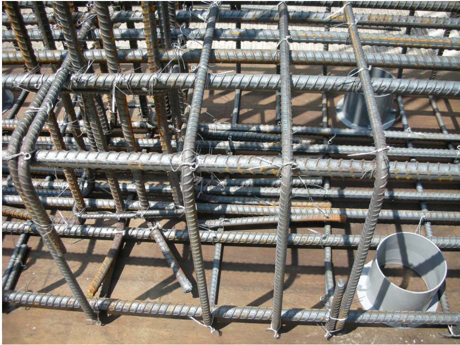
圖 3-13 柱主筋彎入基礎底層筋紮實錨定
