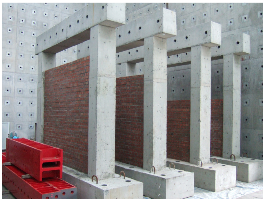
圖 3-23 填充不同高度磚牆試體砌築完成
