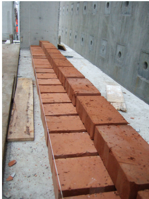
圖 3-10 英式砌法之紅磚堆疊示意圖
