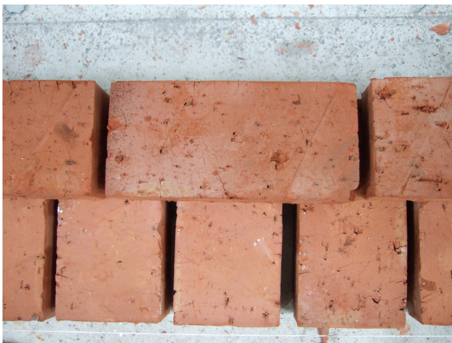
圖 3-11 英式砌法之紅磚堆疊示意圖
