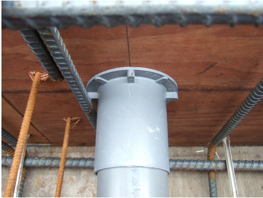
圖 3-19 以專用接頭固定梁之預埋管位置
