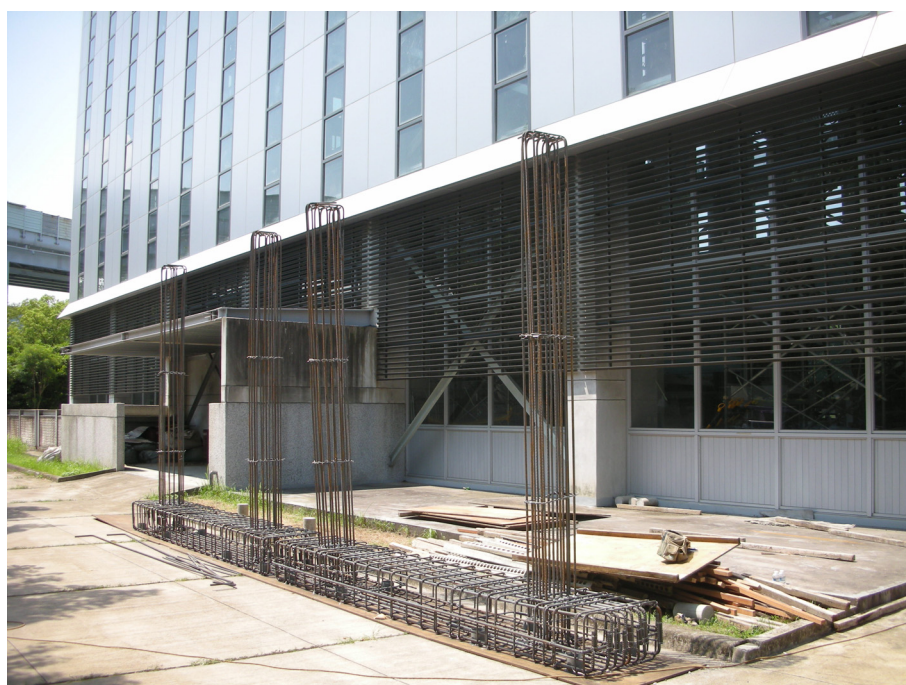
圖 3-12 基礎鋼筋組立
