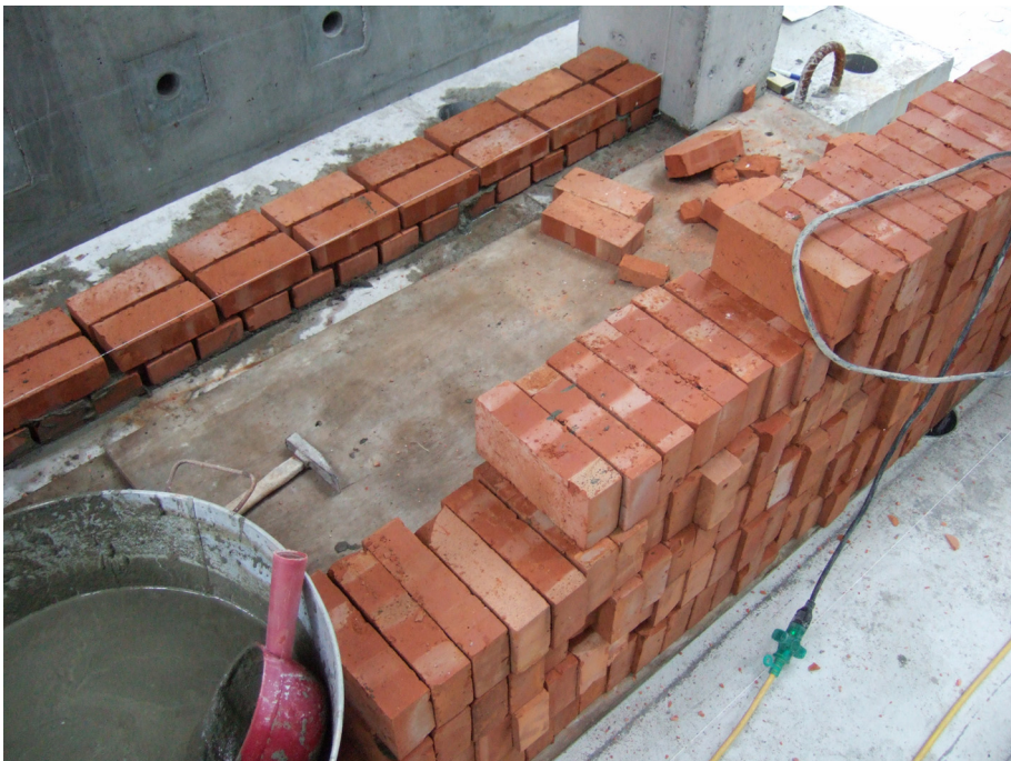
圖 3-22 確認紅磚堆砌方式及水泥砂漿配比
