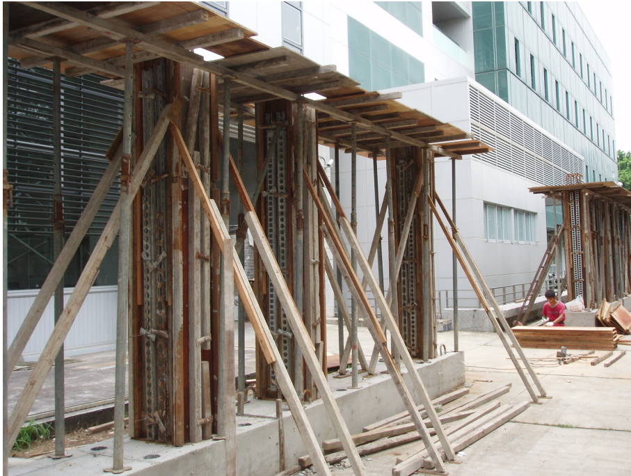
圖 3-17 柱封模板及現場支撐情形
