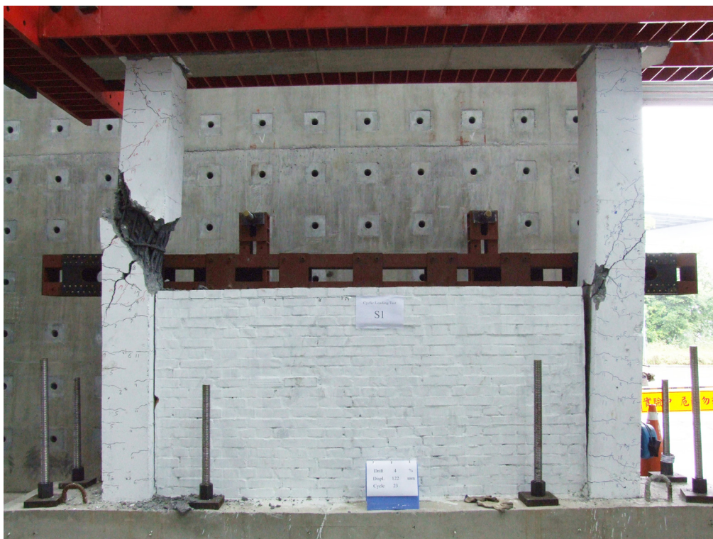
圖 5-9 試體 S1 實驗結束後之破壞情形 (資料來源：本研究製作)
