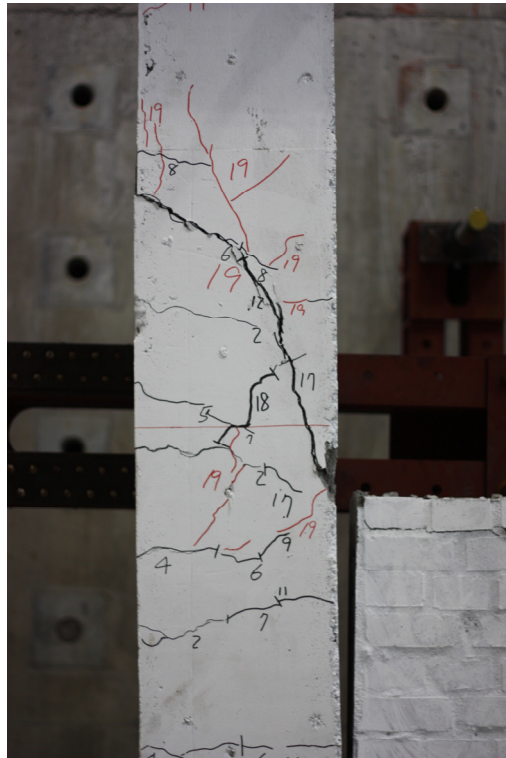
圖 5-7 試體 S1 於位移達 76.25mm 時生斜向裂縫且為極限強度發生點 (資料來源：本研究製作)
