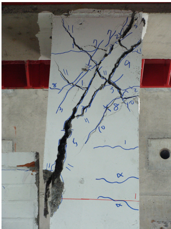
圖 5-25 試體 S4 於位移達 45.75mm 時已產生嚴重的剪力破壞 (資料來源：本研究製作)
