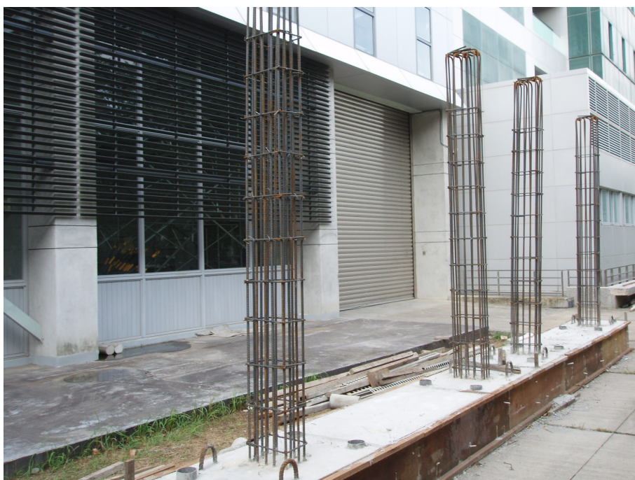
圖 3-16 柱箍筋綁紮完成(間距為 25 公分)
