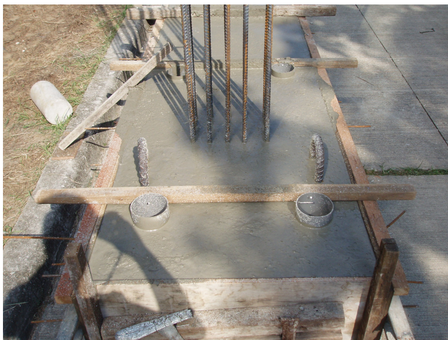
圖 3-15 基礎混凝土澆置完成
