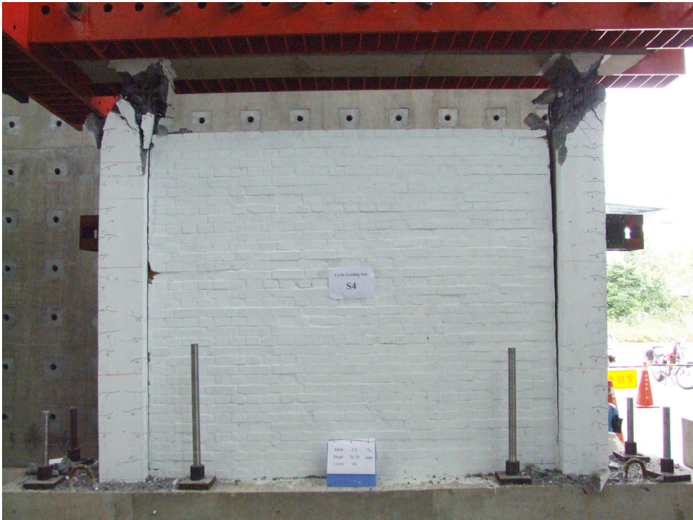
圖 5-27 試體 S4 之最終破壞情形 (資料來源：本研究製作)
