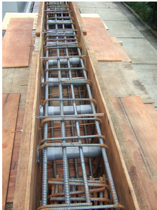
圖 3-18 梁鋼筋組立、裝置預埋管及封模板作業完成
