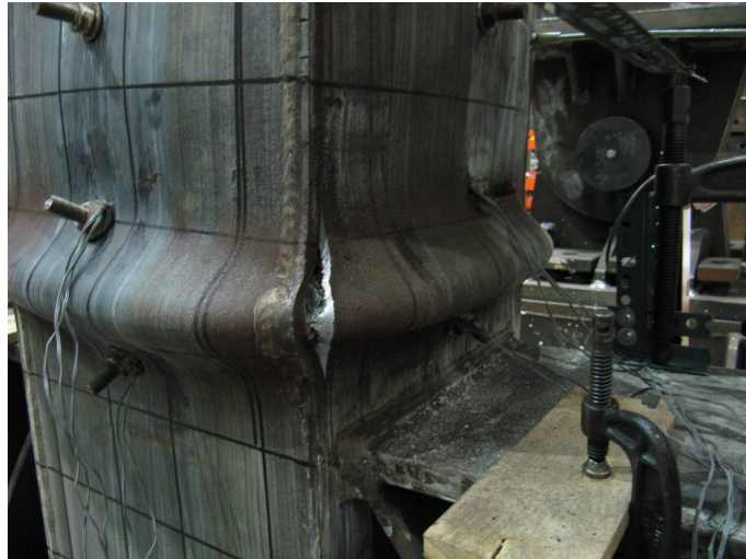
圖 3-24 T40-40-L 試體在側移角 4%時局部挫屈處開裂
