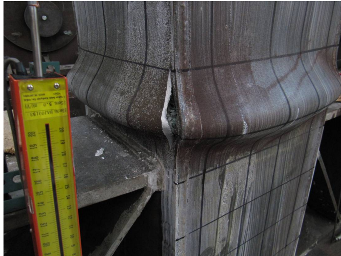
圖 3-9 R40-40 試體在側移角 3%時受壓柱板沿縱向開裂
