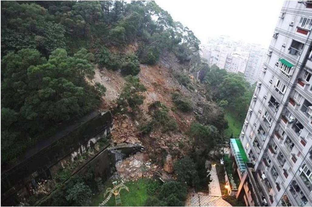
圖2-1 達觀鎮社區擋土牆崩塌
