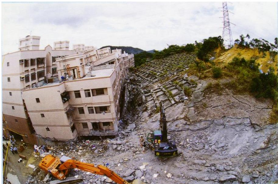
圖1-2 林肯大郡倘土牆破壞照片(廖洪鈞提供)
