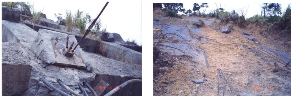
圖1-3 林肯大郡之預力地錨鋼腱射出與錨頭脫落照片(廖洪鈞提供)
